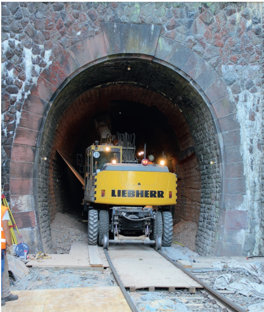
Abb. 5: Fräsarbeiten in Tunnellängsrichtung
