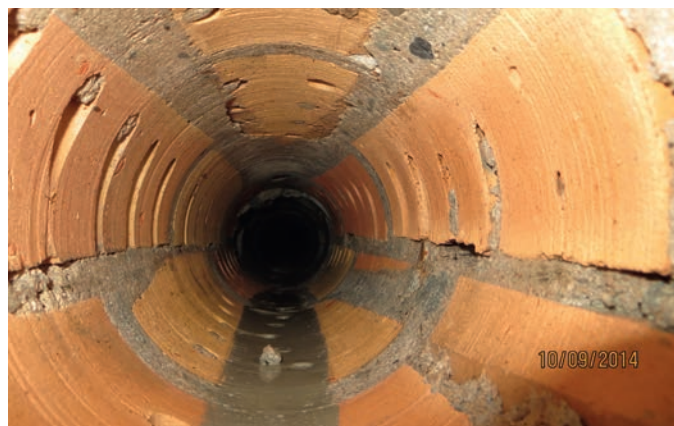
Abb. 3: Kamerabefahrung im Bohrloch
