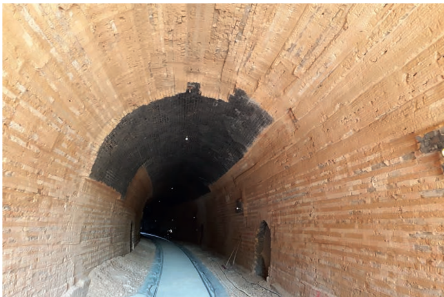
Abb. 6: Zwischenzustand des teilgefrästen Tunnels
