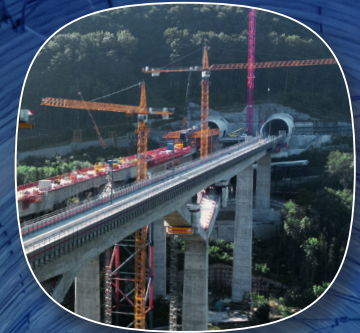
Bauüberwachung NBS Wendlingen-Ulm, PA 2.2, Alaufstieg, Boßlertunnel
