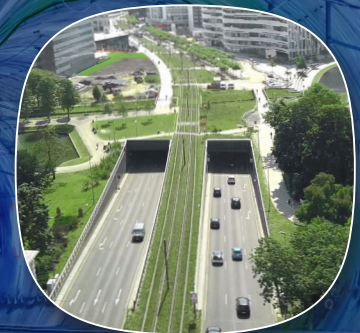
Bauüberwachung Neubau Kö-Bogen-Tunnel
