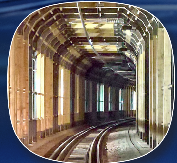
Planung Erneuerung Petersbergtunnel, TiT-Methode unter elektrifiziertem Betrieb
