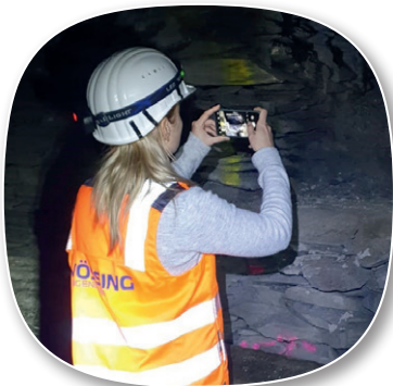
Fledermauskontrolle im Stollen am Cramberger Tunnel
