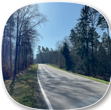
Revierkartierung Bauabschnitt 2 beim Ausbau der Landesstraße L205
