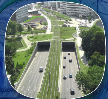
Bauüberwachung Neubau Kö-Bogen-Tunnel
