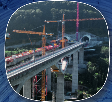
Bauüberwachung NBS Wendlingen-Ulm, PA 2.2, Alaufstieg, Boßlertunnel
