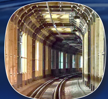
Planung Erneuerung Petersbergtunnel, TiT-Methode unter elektrifiziertem Betrieb
